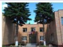
Корпус «Жемчужинка» г. Коломна, ул. Весенняя д. 28
